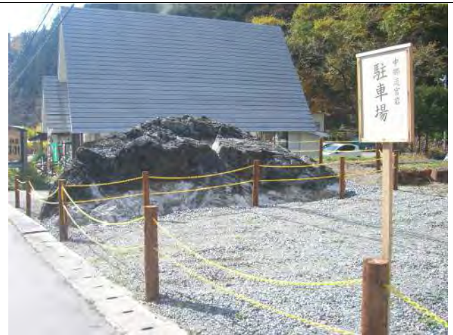
説明 完成写真 程野方面から
